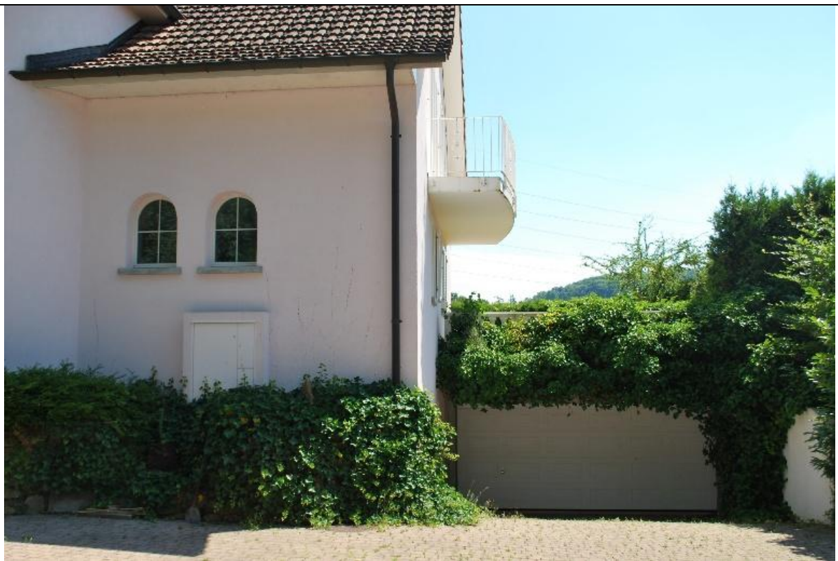
Garageneinfahrt von Strassenseite
