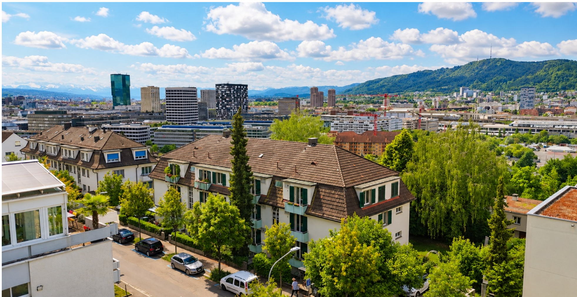
Blick nach Südosten | Höhe - Ausbau Attikageschoss
