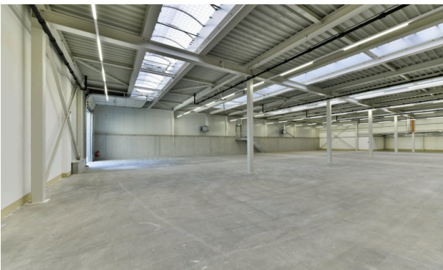
Lagerhalle ohne Mieterunterteilung
