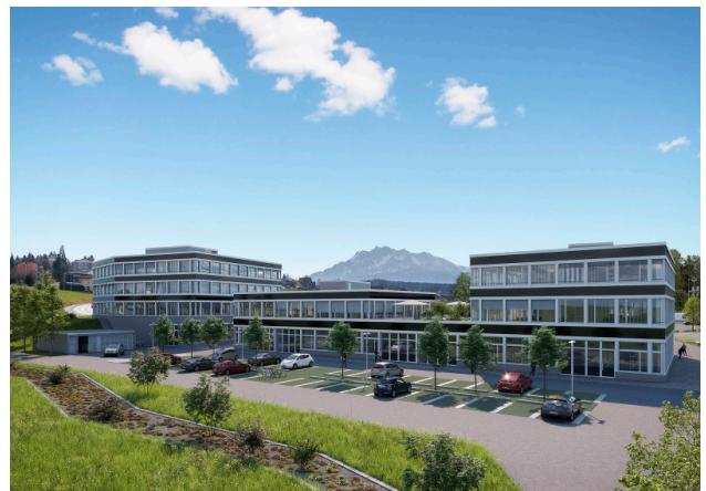
Rückseite der Gebäude 1, 3, 5 (von links)
