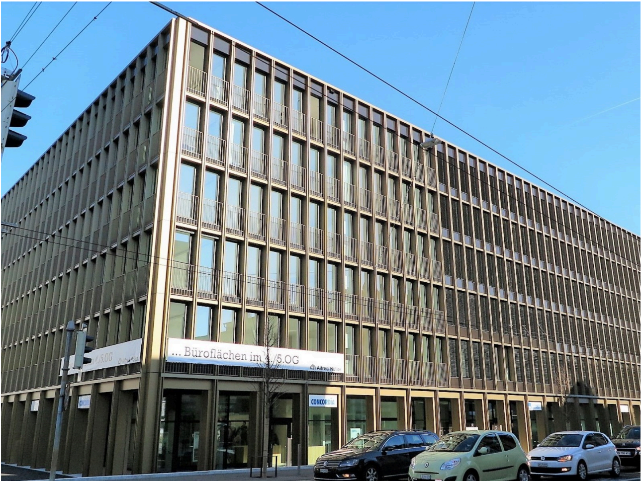
Zentrum Pilatus, West-/Südfassade
