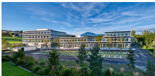
Rückseite der Gebäude 1, 3, 5 mit Pilatusblick
