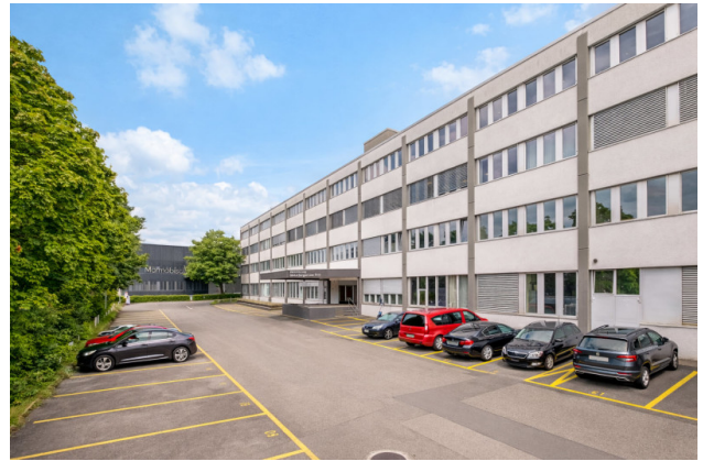
Aussenansicht mit Anfahrrampe und Parkmöglichkeiten
