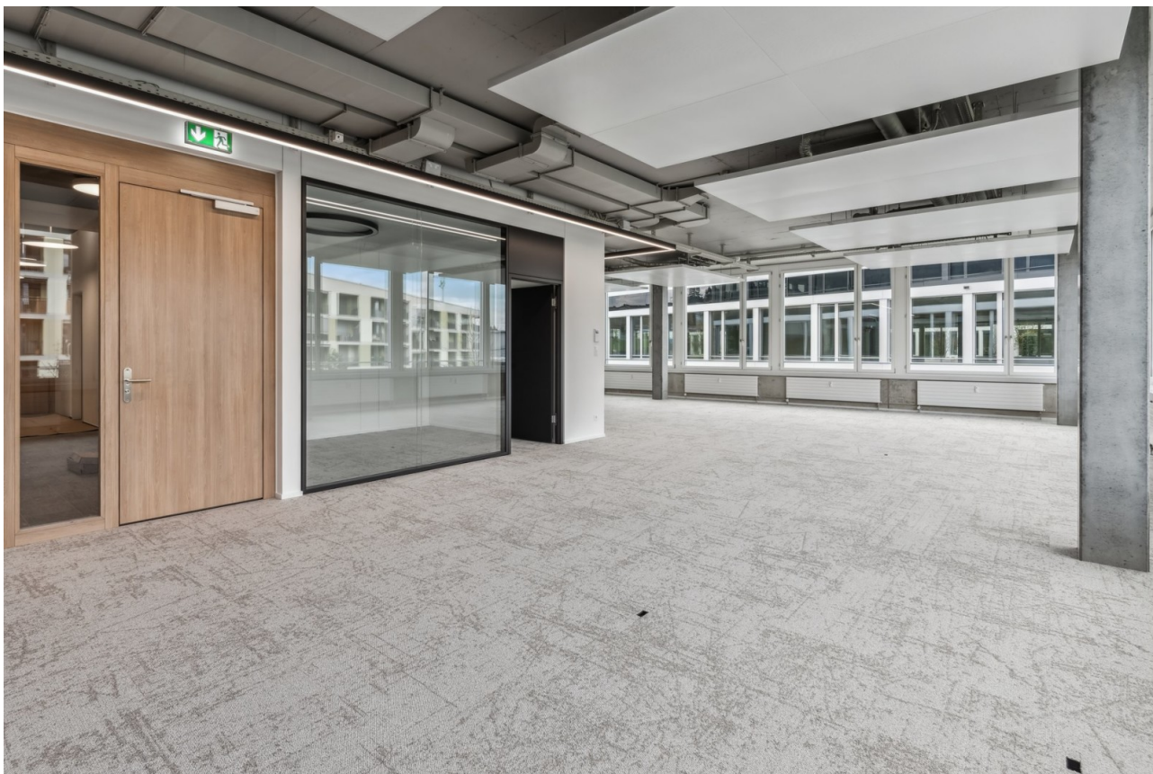
Eingangsbereich mit Sitzungszimmer
