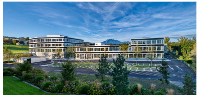
Rückseite der Gebäude 1, 3, 5 mit Pilatusblick
