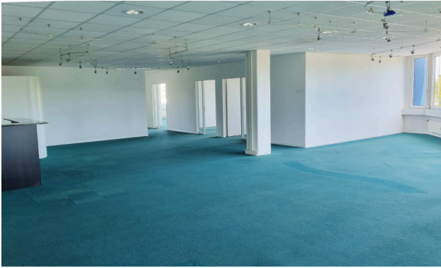
Grossraumbüro und Eingangsbereich mit bestehendem Innenausbau
