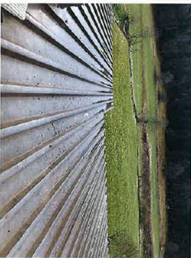
Toiture rez de chaussé
