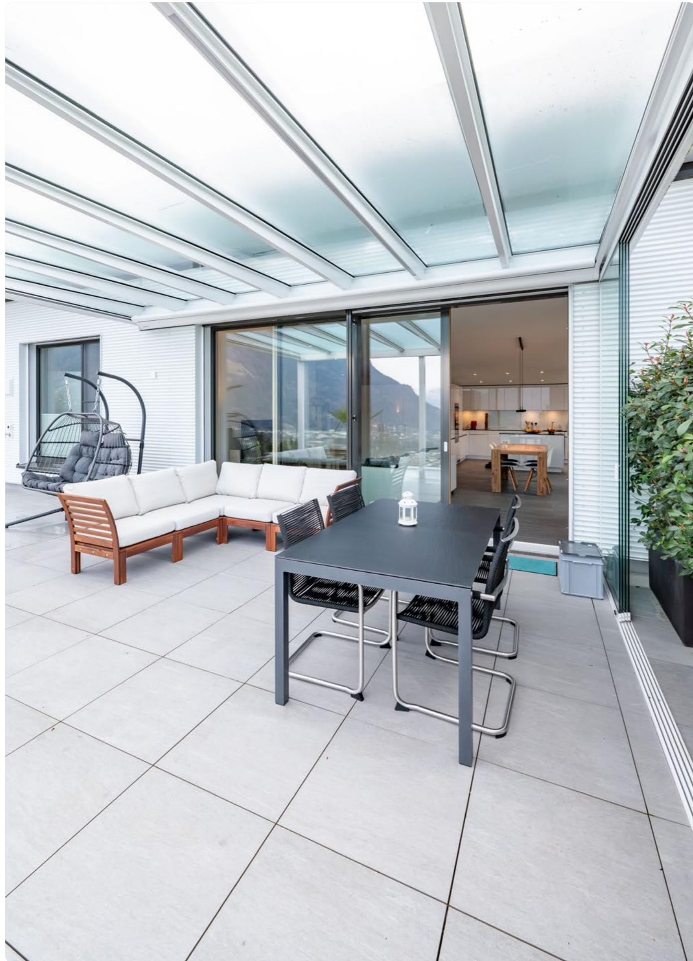
Pergola mit Beschattung und LED-Beleuchtung von «weinor»
