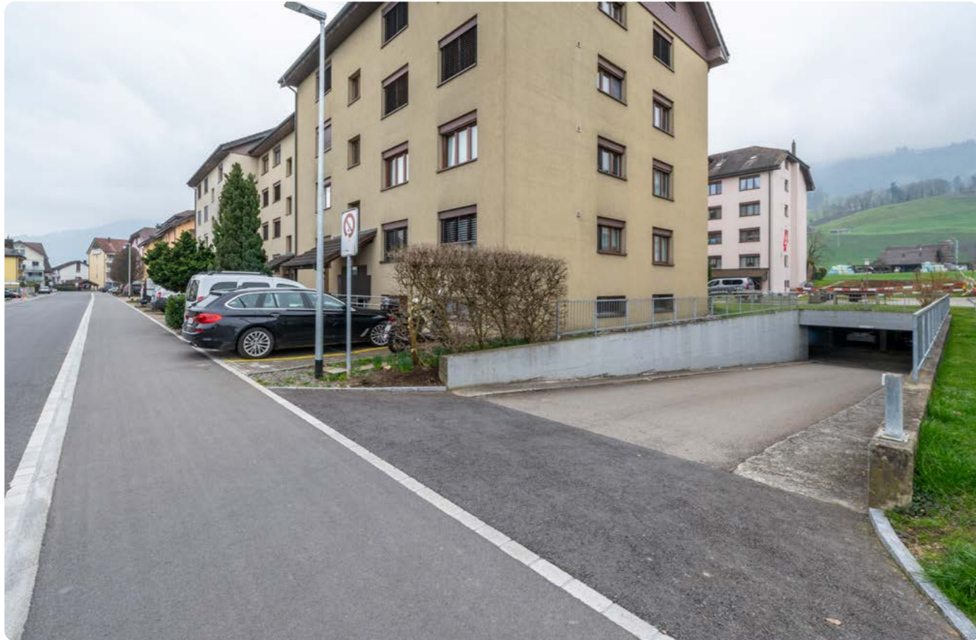
Tiefgarageneinfahrt beim Nördlingerhof 6c
