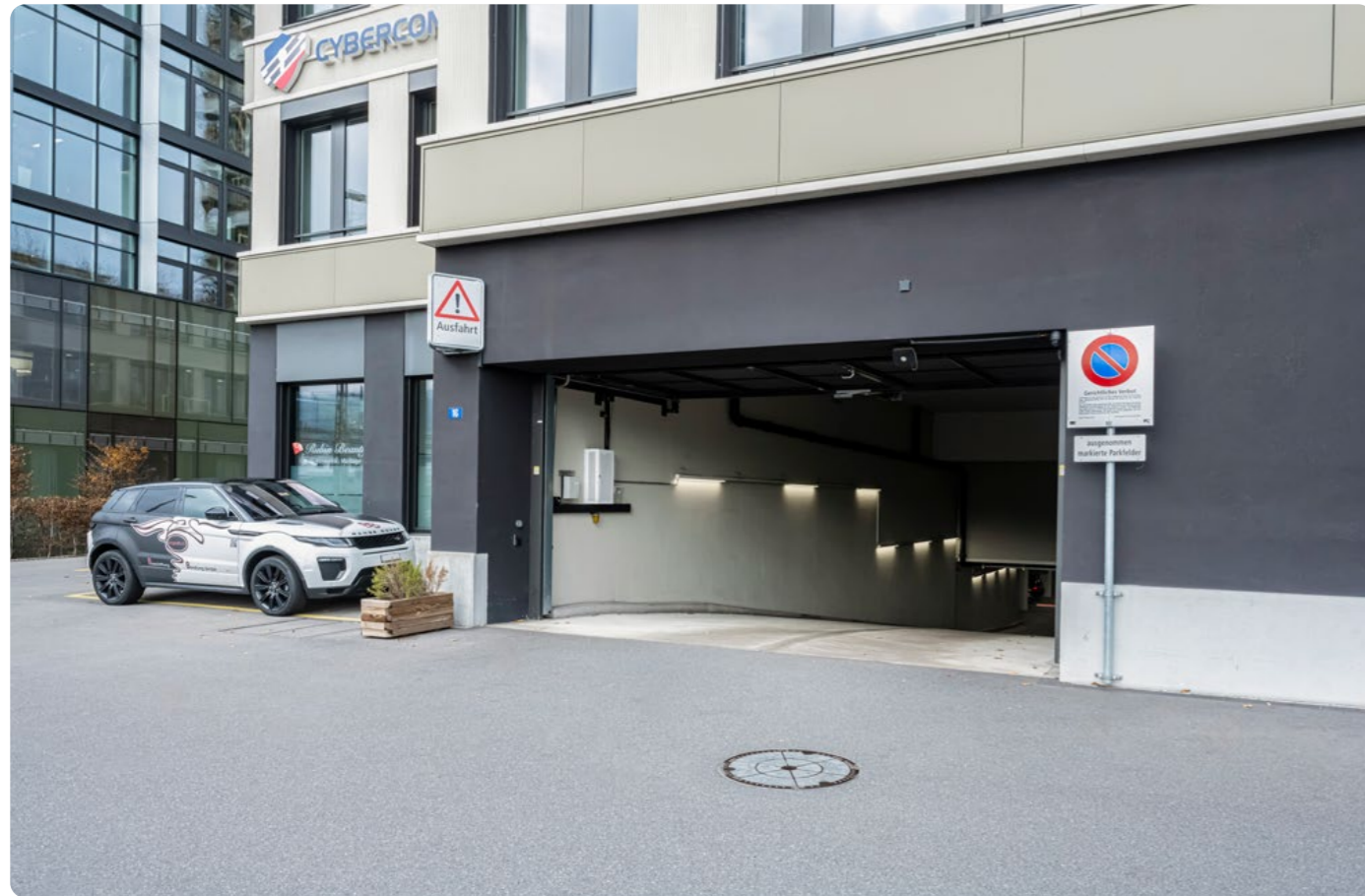
Tiefgarageneinfahrt an der Suurstoffi 16
