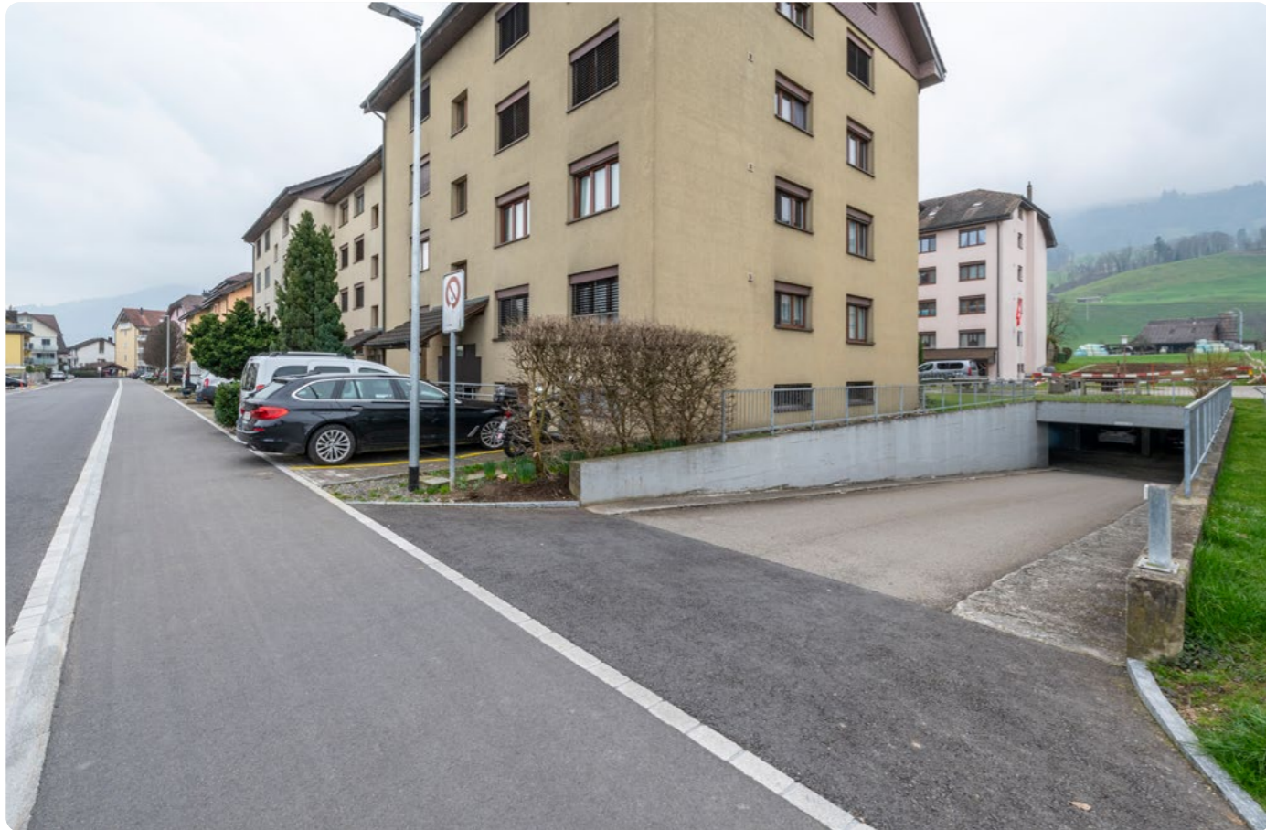
Tiefgarageneinfahrt beim Nördlingerhof 6c
