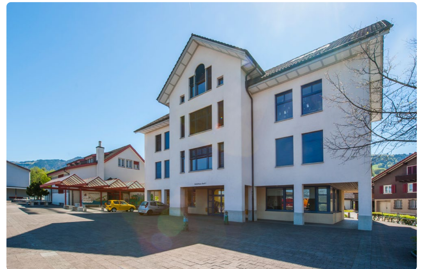
Schulhaus «Dorf» in Galgenen mit Primarschule
