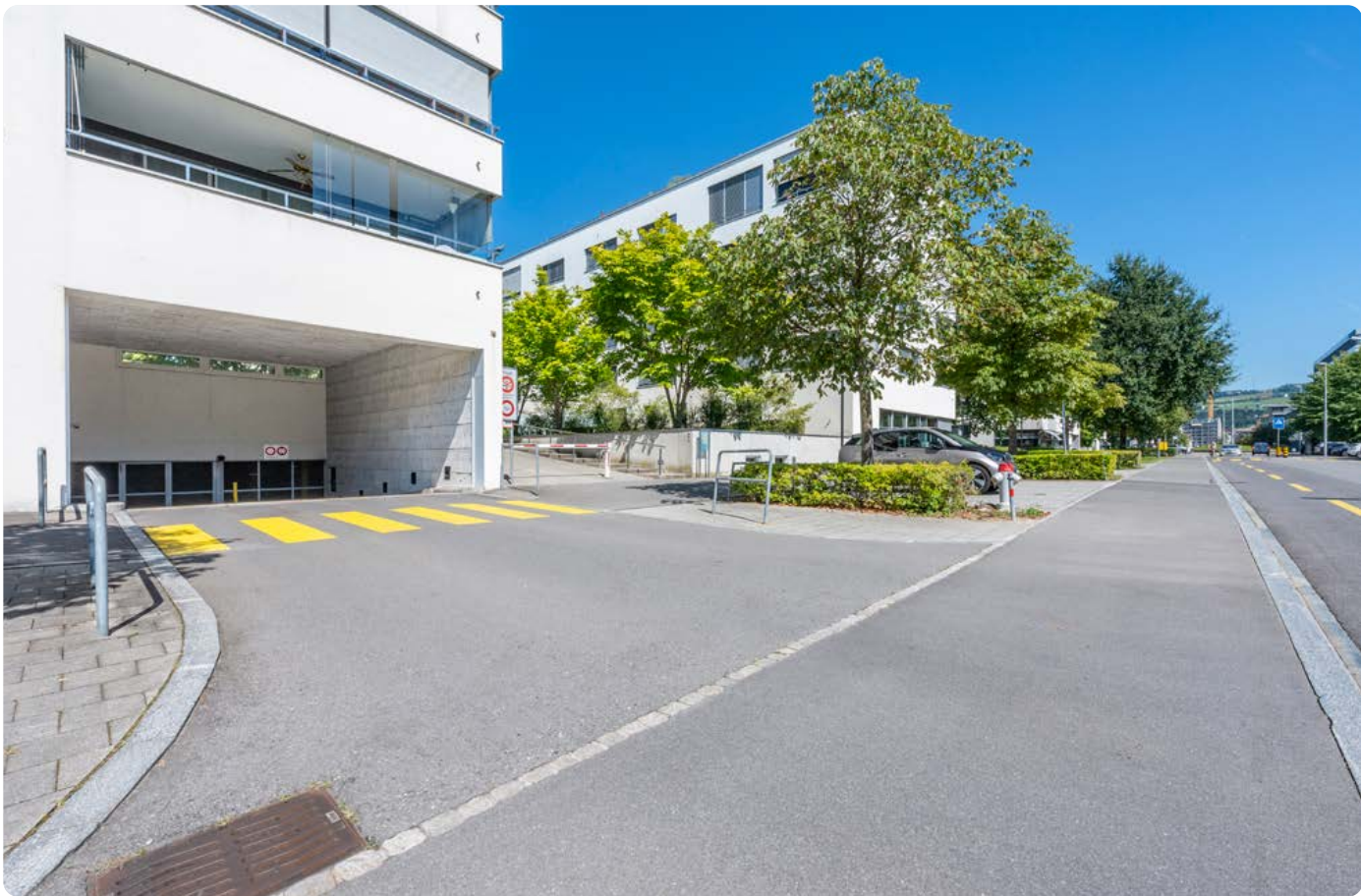
Tiefgarageneinfahrt an der Feldstrasse 1
