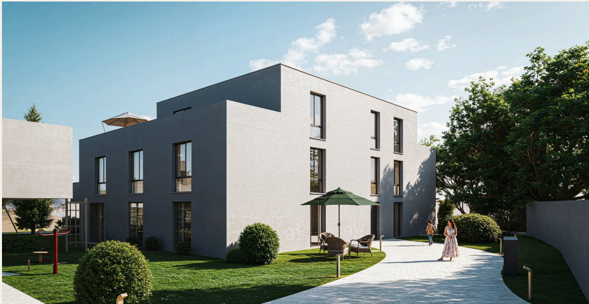
— ANSICHT Blick auf einen der drei Häuser mit den dazwischenliegenden Verweilzonen
