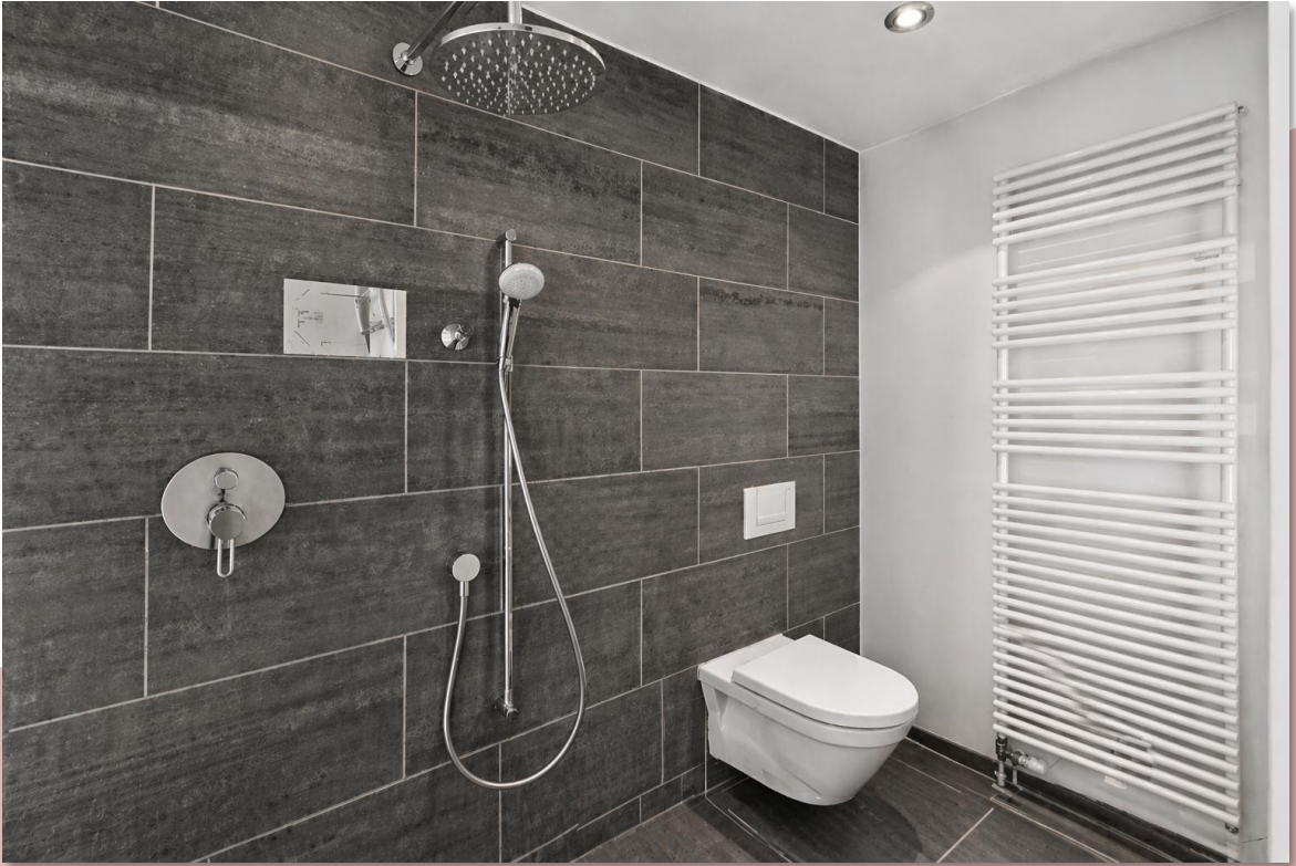
Dusche mit WC | Loft EG
