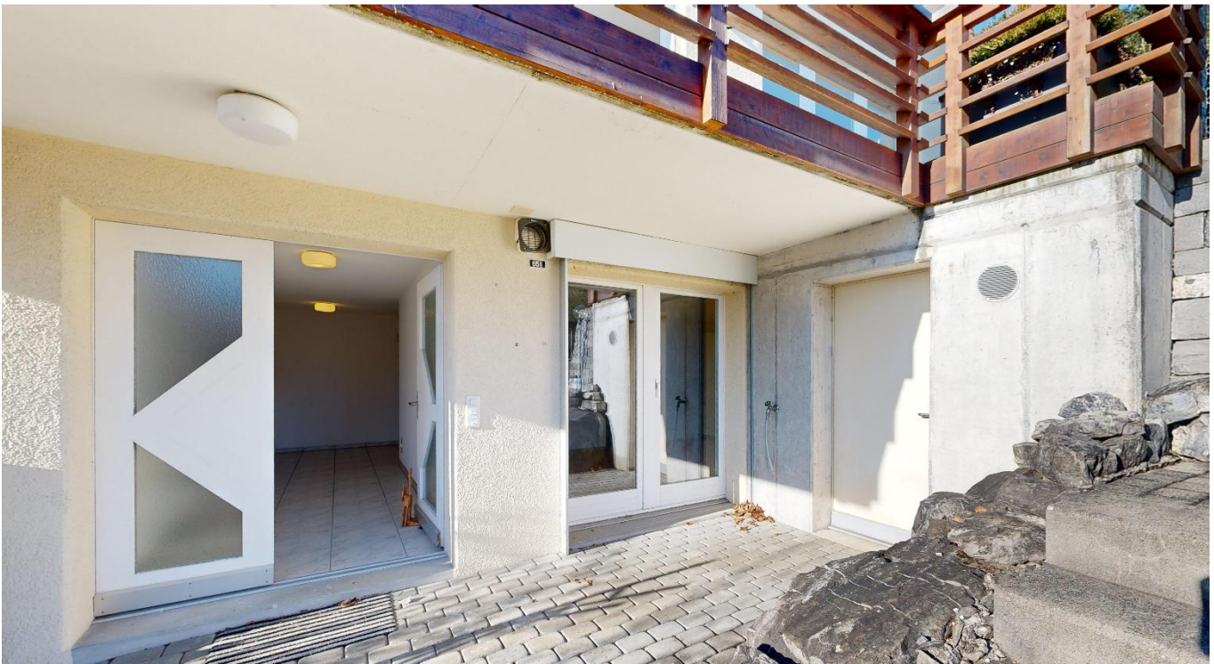
Vorplatz/Eingangsbereich mit Geräteraum (UG)
