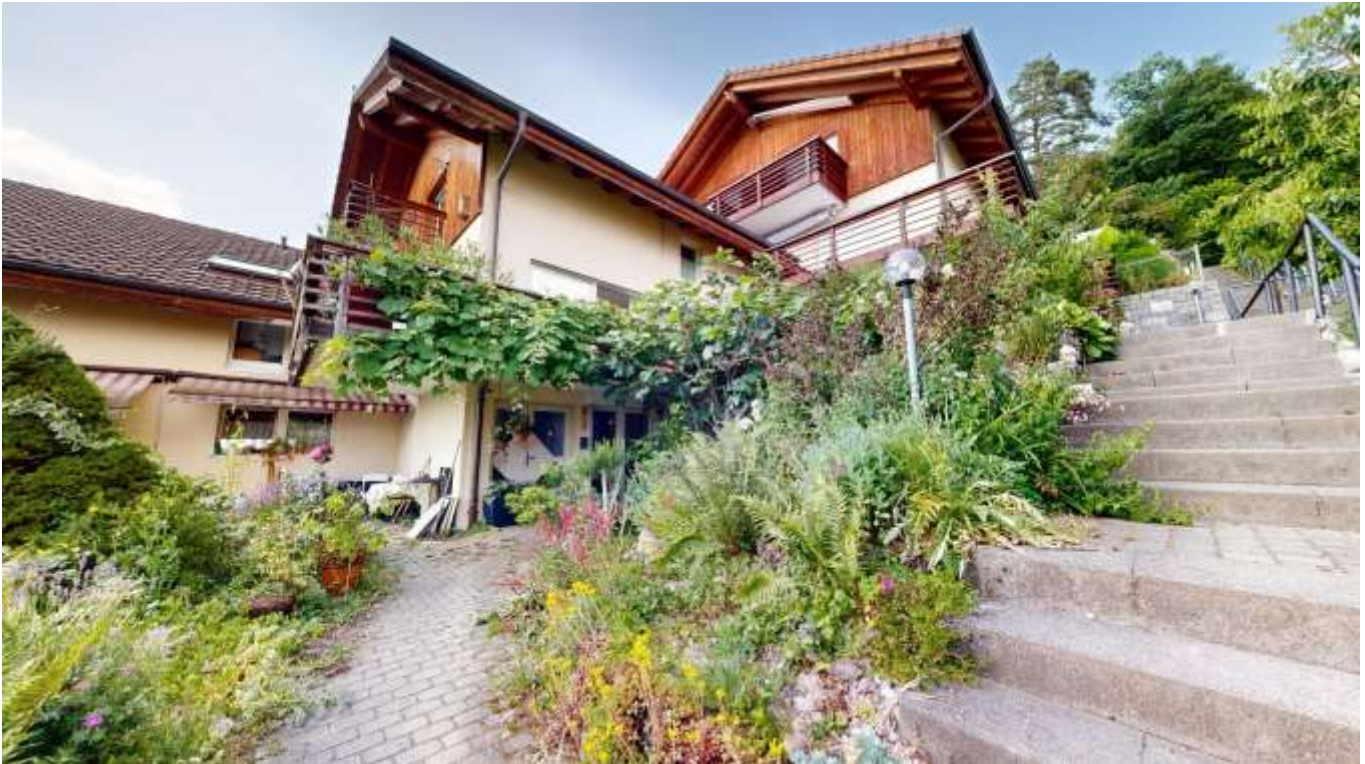
Charmantes 5 ½ (6) Zimmer-Reihen-Einfamilienhaus (Mittelhaus) an sonniger Lage
