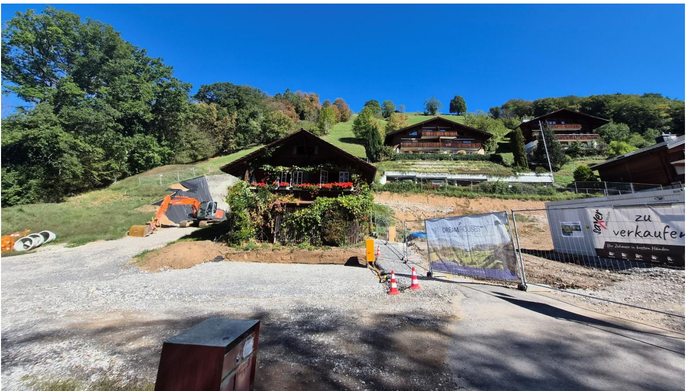
Aushub/Baubeginn 2026 (Bezug ca. Frühling 2028)
