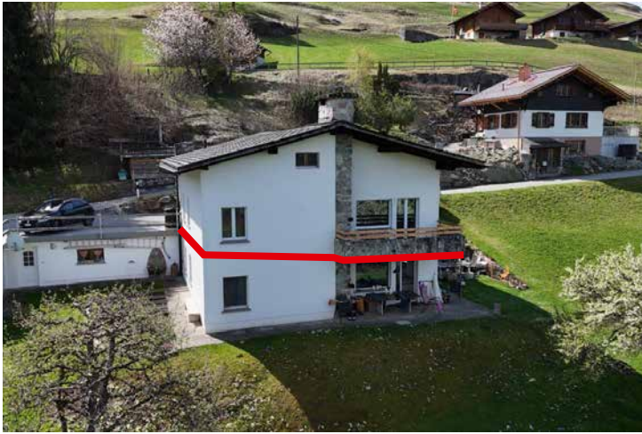
Die 4½-Zimmer-Wohnung im 1. Obergeschoss mit ausbaubarem Estrich
