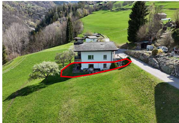
Die 4½-Zimmer-Wohnung im Erdgeschoss mit grossem Gartenanteil
