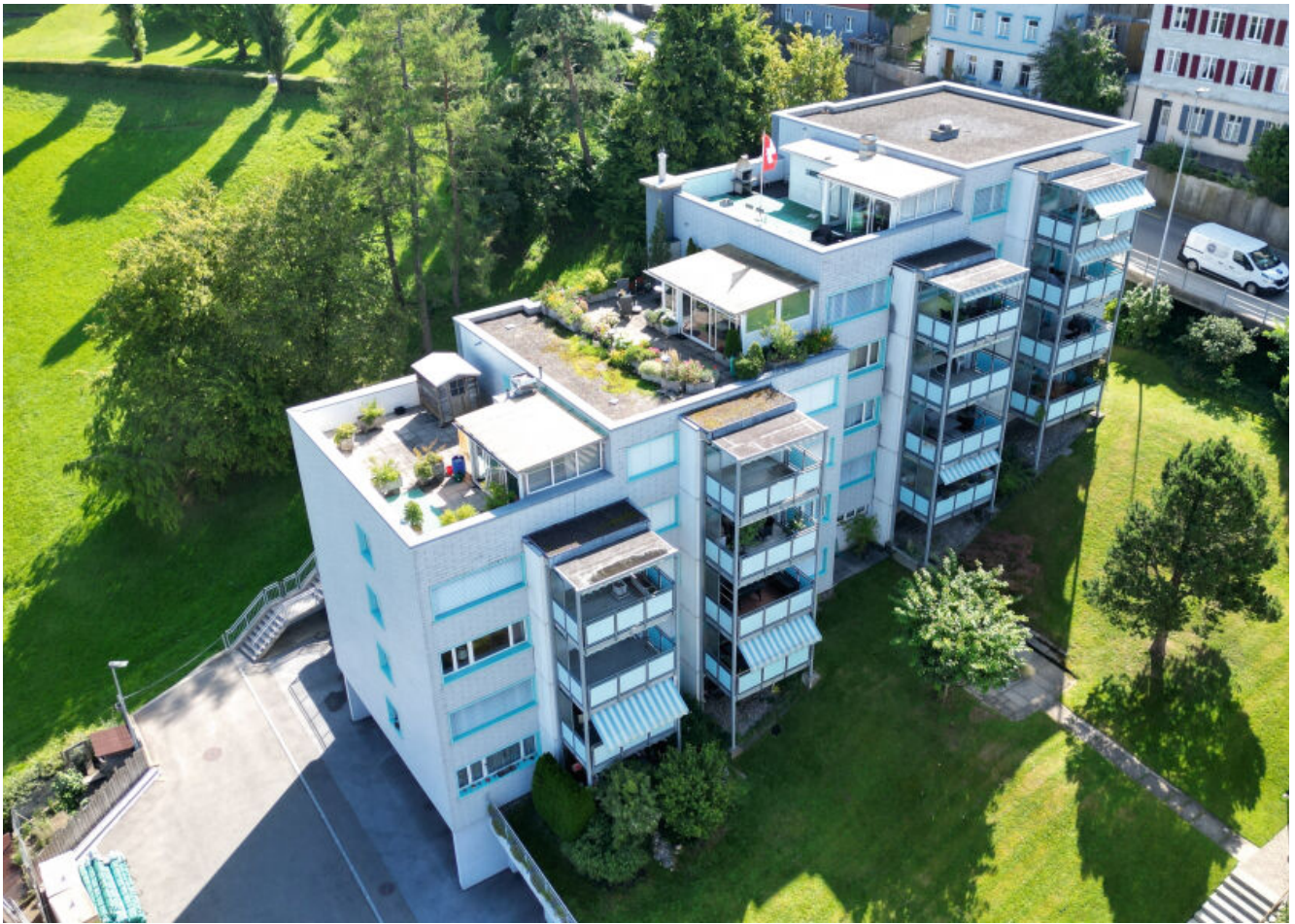
Wohnüberbauung untere Steinegg
