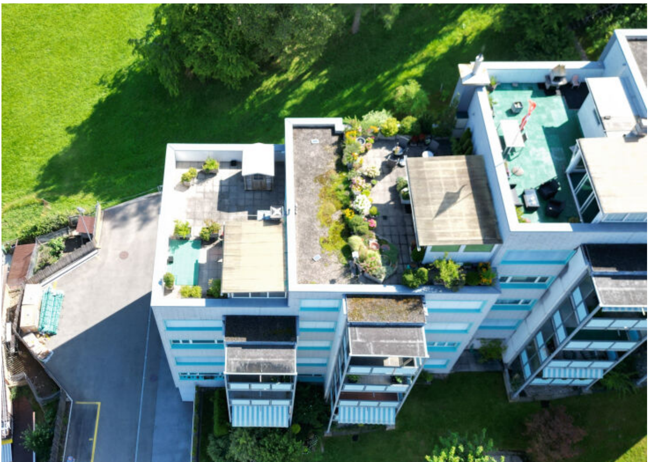
Wohnüberbauung untere Steinegg
