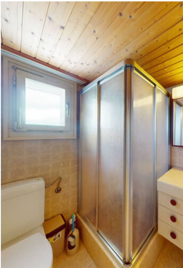
Die Nasszelle ist mit einem WC, einer Duschkabine...
