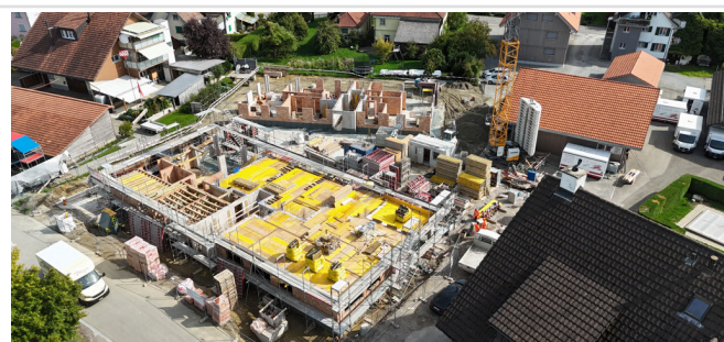
Baustelle Dozwil · Aufnahme 17.09.2026
