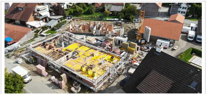
Baustelle Dozwil · Aufnahme 17.09.2026
