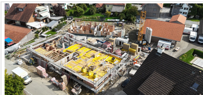
Baustelle Dozwil · Aufnahme 17.09.2026
