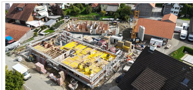
Baustelle Dozwil · Aufnahme 17.09.2026
