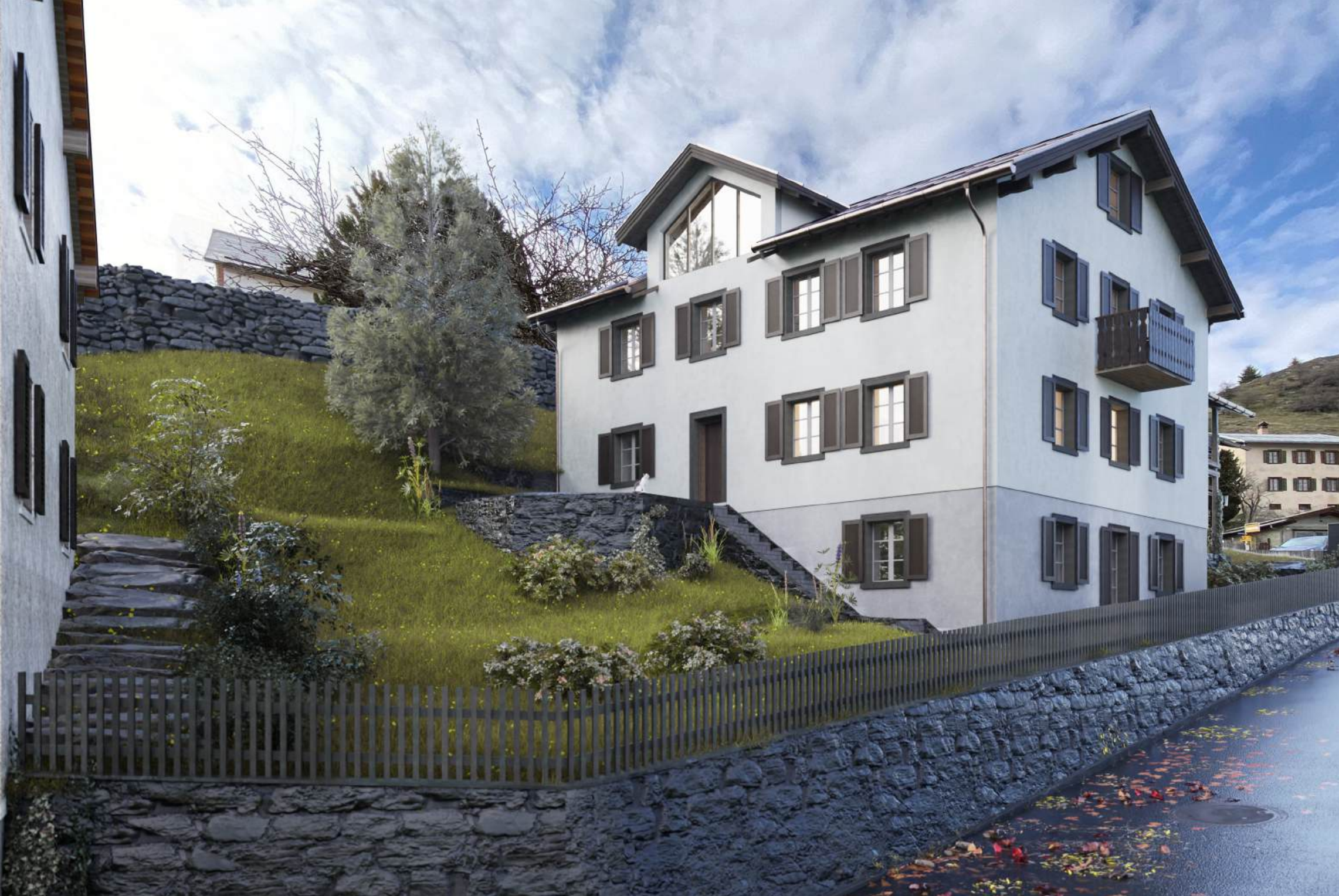
SÜDWESTANSICHT MIT AUSSENBEREICH
