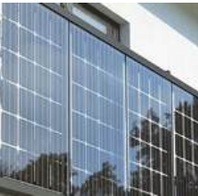
Südost und Südwest Fassade
