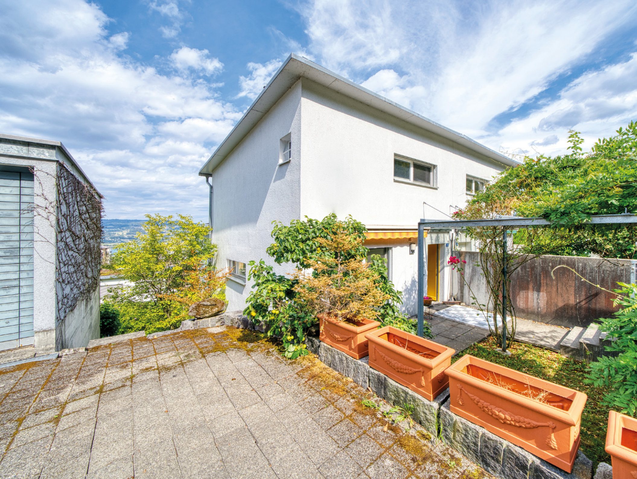
EINGANG MIT GARAGENPLATZ
