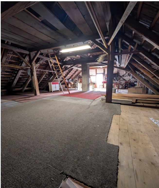
Dachstock im heutigen Zustand
