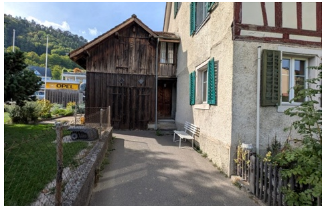
Seitliche Hausansicht und Zufahrt Zürichstrasse
