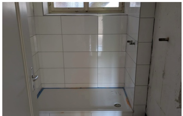
EG · Bad, erneuert 2025
