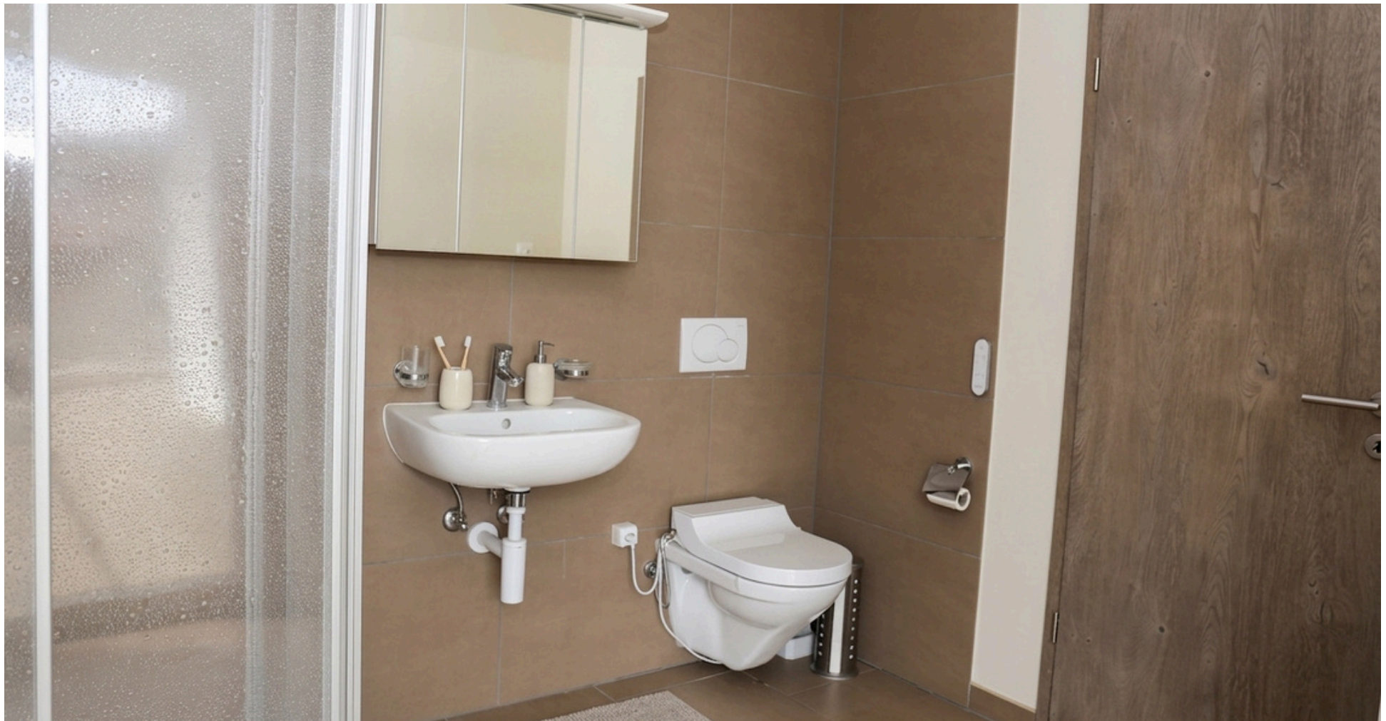
Salle de douche avec WC et machine à laver
