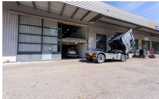
Lage des Gebäudes
