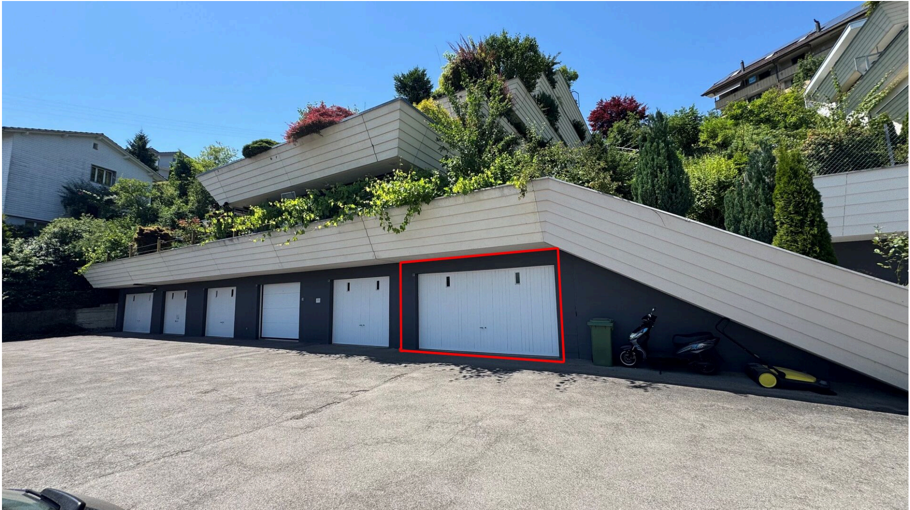
Garage auf Ebene Zugang unten
