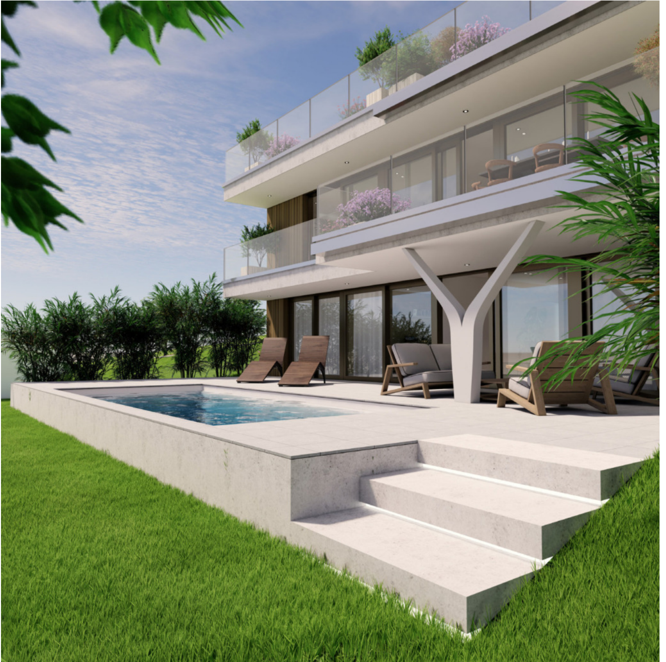
Ansicht aus Süden - Sockelgeschoss
