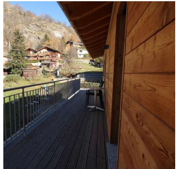
Abbildung 10: Balkon, Archiv Holzbau AG
