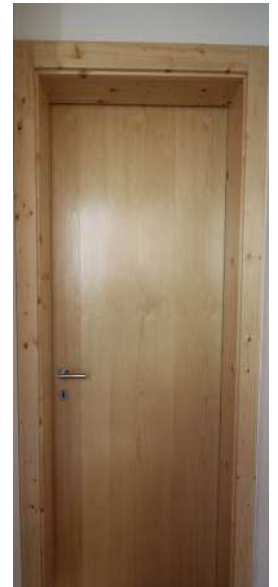
Abbildung 14: Tür 2, Archiv Holzbau AG
