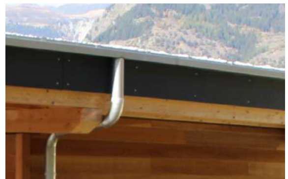
Abbildung 11: Dach, Archiv Holzbau AG
