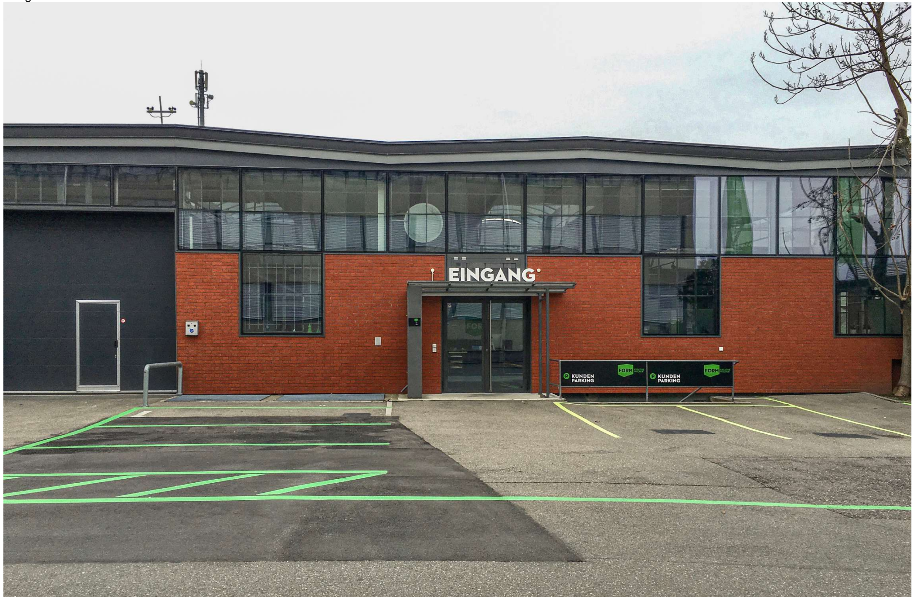
Zufahrt / Anlieferung Mittelhalle Nord, Eingang Creativ Halle Büro
