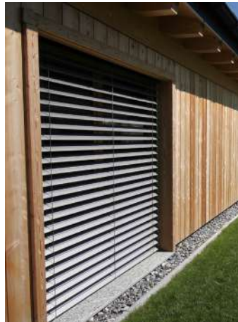
Abbildung 12: Sonnenschutz 1, Archiv Holzbau AG
