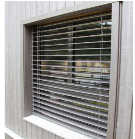
Abbildung 13: Sonnenschutz 2, Archiv Holzbau AG
