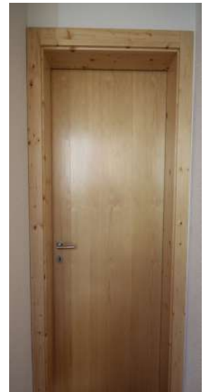
Abbildung 7: Türe 2, Archiv Holzbau AG
