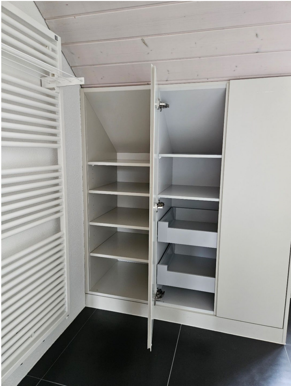
Einbauschränk im Bad oberer Stock
