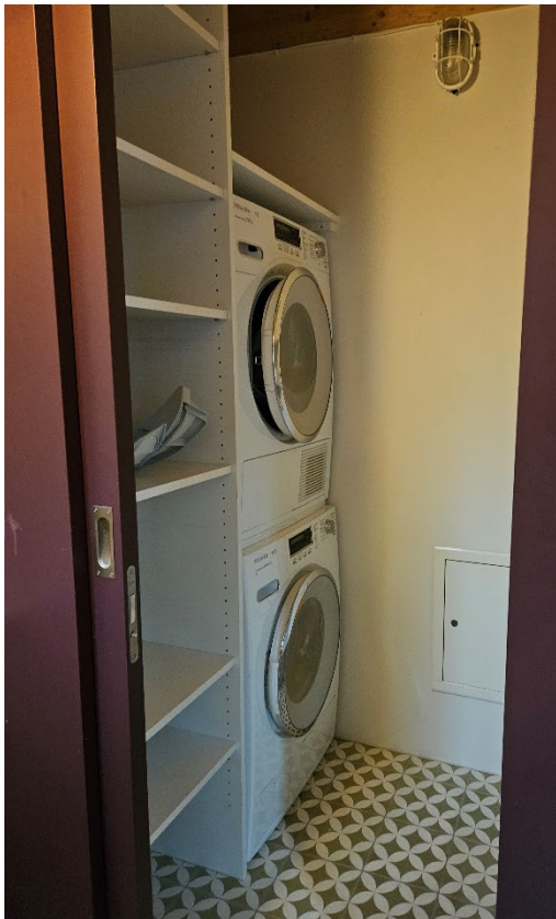
Gäste-WC mit eingebautem Reduit
