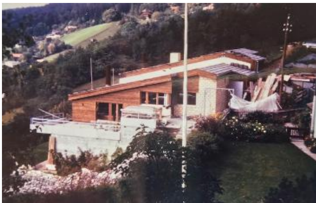
Die Südausrichtung bietet mehrere Terrassen (1976)
