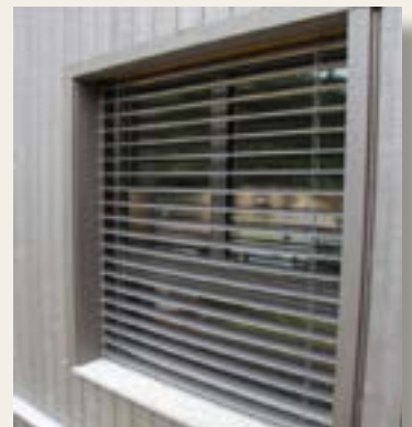
Abbildung 16: Sonnenschutz 2, Archiv Holzbau AG
