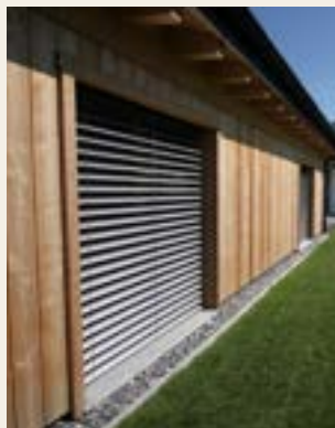
Abbildung 15: Sonnenschutz 1, Archiv Holzbau AG
