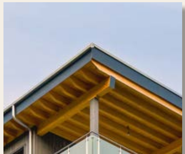
Abbildung 8: MFH Dachrinne, Archiv Holzbau AG
