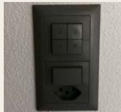
Abbildung 13: E-Inst., Archiv Holzbau AG
