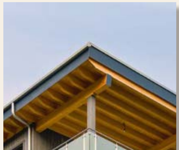
Abbildung 8: MFH Dachrinne, Archiv Holzbau AG
