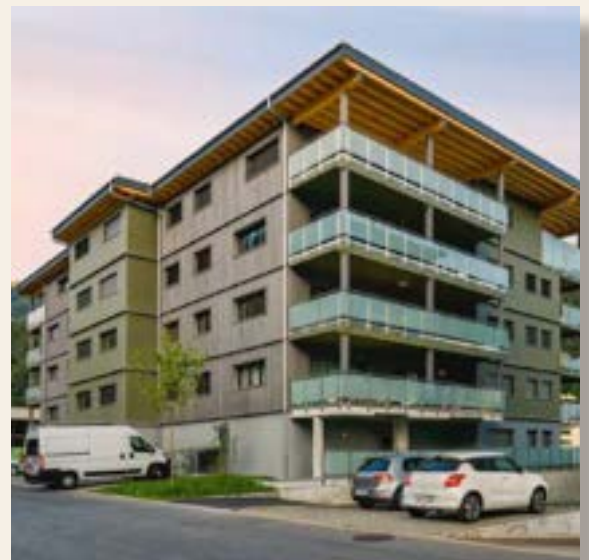
Abbildung 7: MFH Balkon, Archiv Holzbau AG
