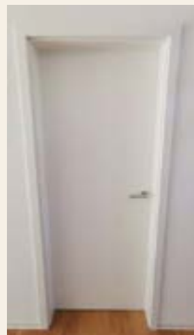
Abbildung 10: Tür 1, Archiv Holzbau AG
