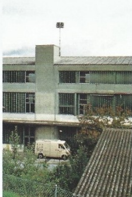
Die ehemalige Garage vor dem Umbau. Bild: Aarplan
