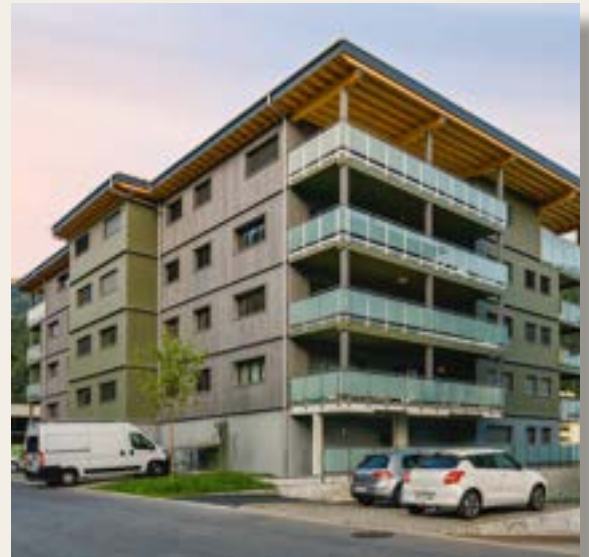
Abbildung 7: MFH Balkon, Archiv Holzbau AG
