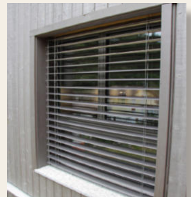
Abbildung 15: Sonnenschutz 2, Archiv Holzbau AG
