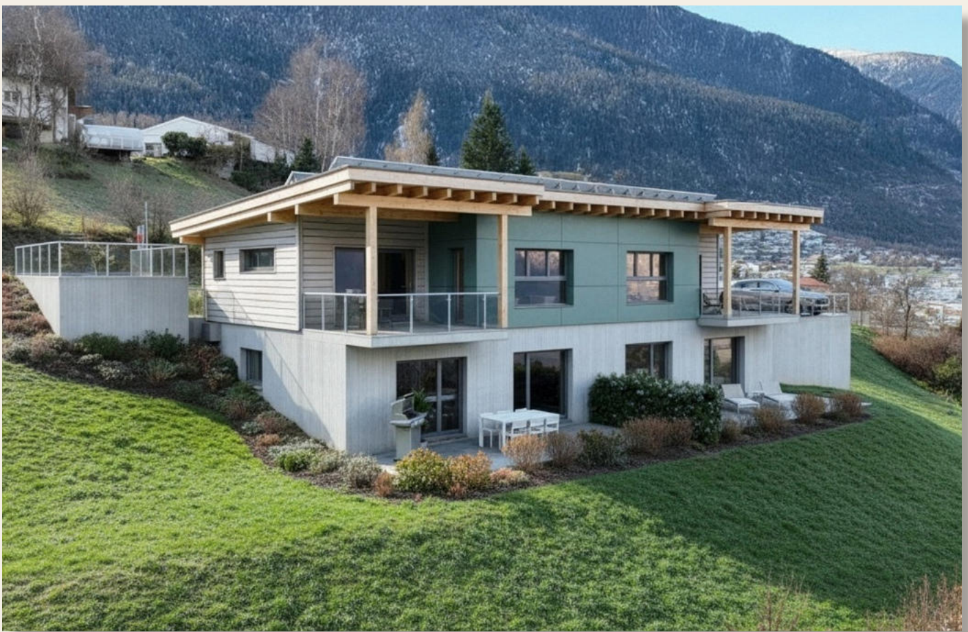
Abbildung 2: Visualisierung Aussenansicht, Archiv Holzbau AG
