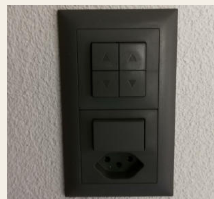
Abbildung 12: E-Inst., Archiv Holzbau AG
