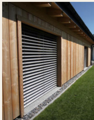
Abbildung 14: Sonnenschutz 1, Archiv Holzbau AG
