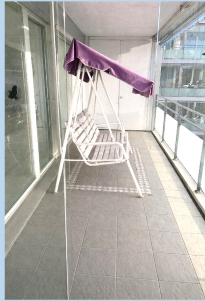
Balkon mit Geräteraum
