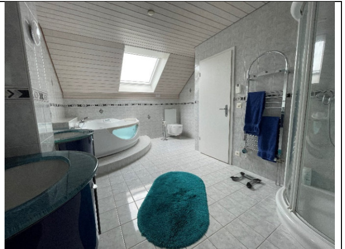
Dachflächenfenster mit Aussenrollladen solarbetrieben
