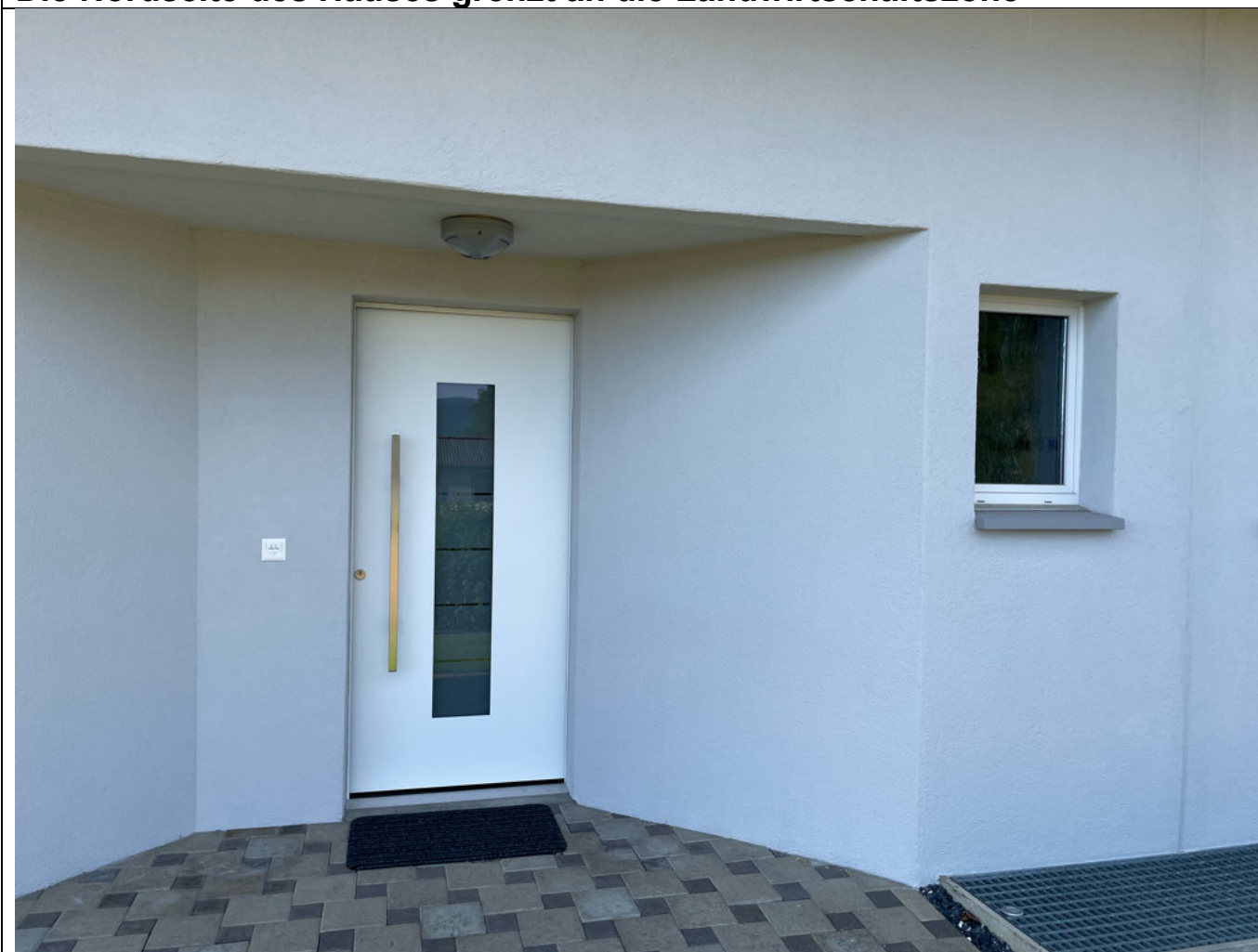
Haupteingang im Erdgeschoss
