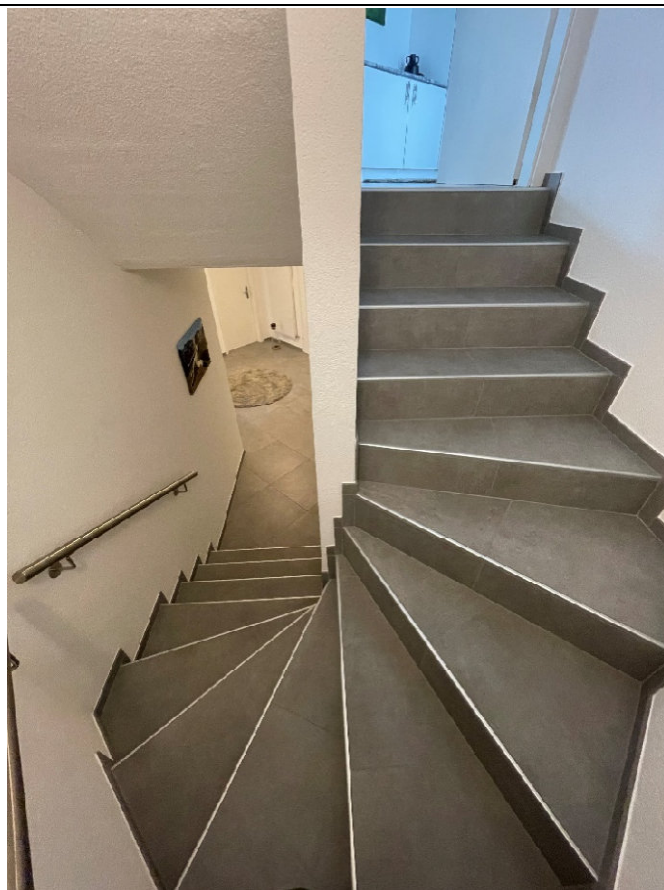
Treppenhaus UG ins EG
