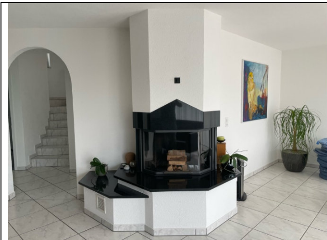
Cheminée mit Warmluftumwälzung
