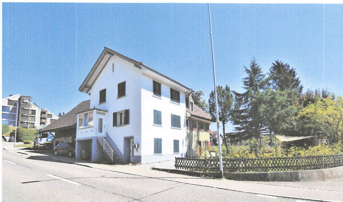
Ansicht von der Kantonsstrasse her
