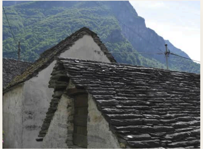
DACH AUS PIODE
